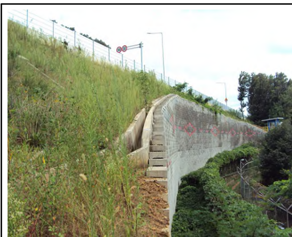
위 치 시점부 현 황 전경
