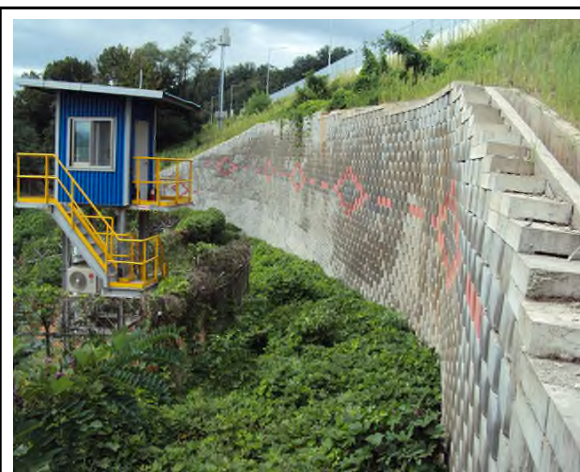
위 치 중점부 현 황 중점부 전경
