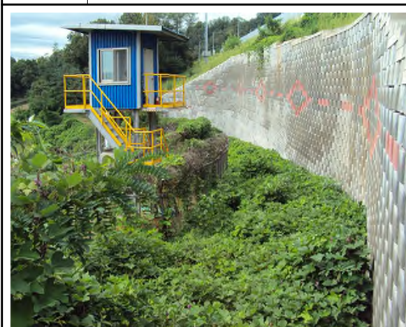
위 치 전면 하부 현 황 전경
