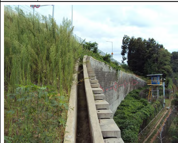
위 치 상부 배수로 현 황 전경
