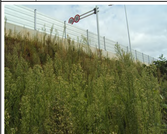
위 치 상부 현 황 전경
