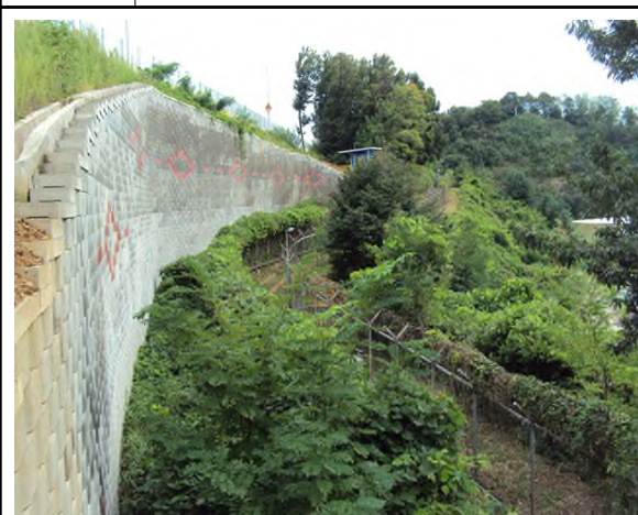
위 치 전면 하부 현 황 전경
